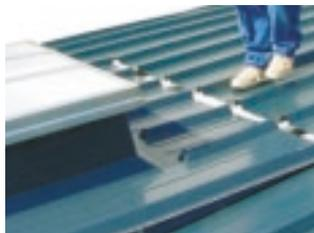
7° Mettre en place le double joint en mastic polyuréthane (indispensable), transversalement sur la partie haute de l'embase.
