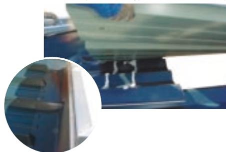
9° Mettre en place le double joint en mastic polyuréthane (indispensable), transversalement sur le bac, en dessous de la partie basse de l'embase.
